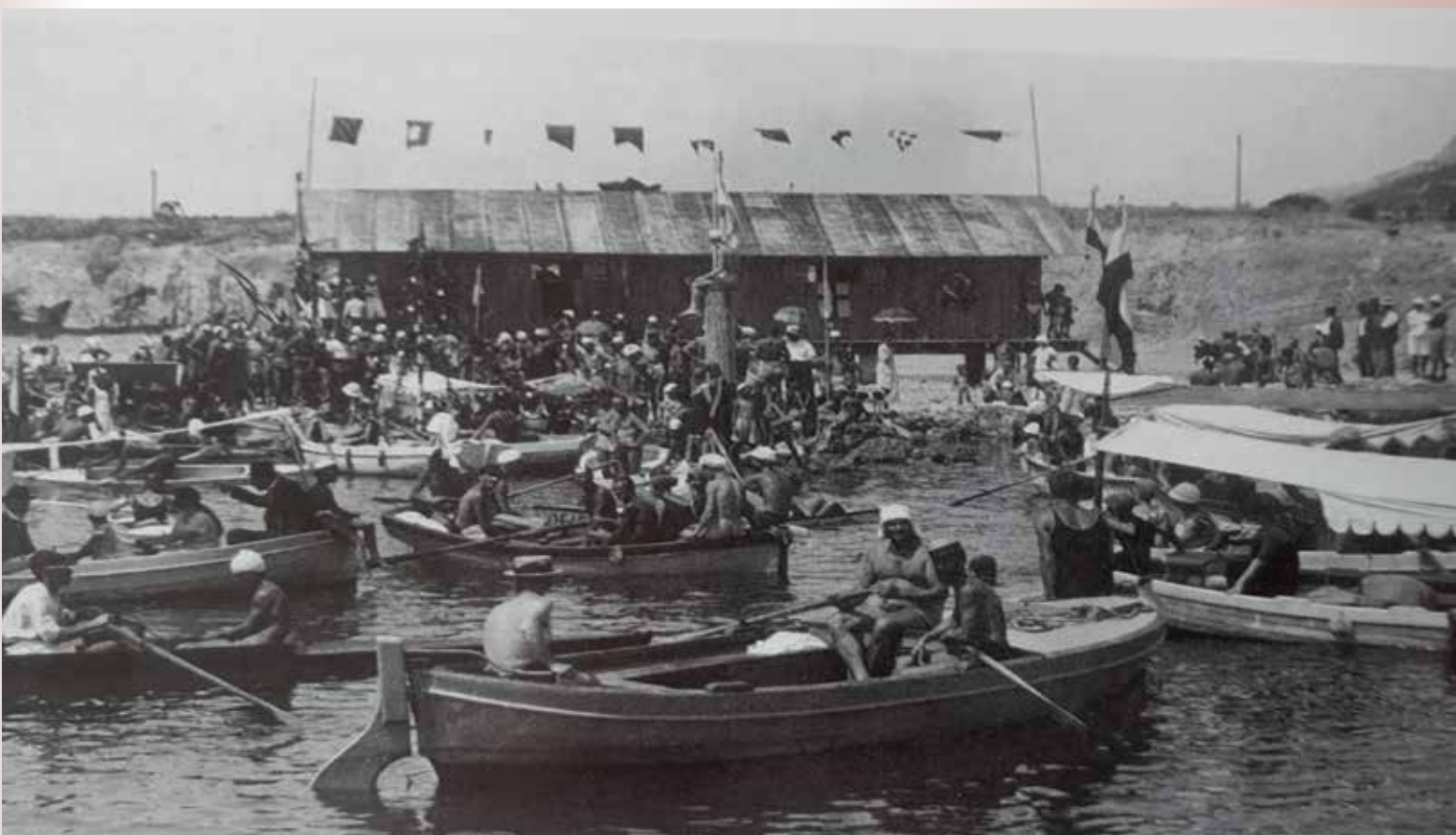
Klupski dom Baluni otvoren je 24.srpnja 1921. Ovaj drveni dom ležao je na betonskim stupovima
